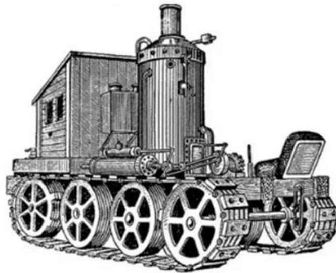
Первый гусеничный трактор конструкции А. Ф. Блинова имел два паровых двигателя. За 1 ч он расходовал 5 кг топлива, у которого удельная теплота сгорания равна  $30 \cdot 10^6 \frac{\text{Дж}}{\text{кг}}$ . Вычислите КПД трактора, если мощность двигателя его была равна около 1,5 кВт.
